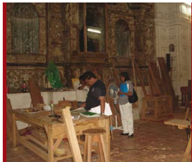
Restauración del Altar No.4 y Pulpito de la Iglesia Colonial de San Cristóbal Acasaguastlán, Departamento El Progreso. Taller donde se restaura el retablo #4 y púlpito.
